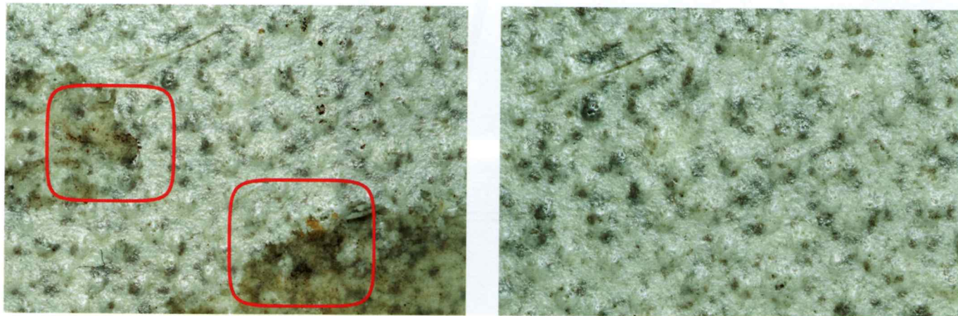
Im Bild links sind im roten Kreis anhaftende, klebrige Verschmutzungen vor der Reinigung sichtbar. Rechts sieht man den trittsicheren keramischen Belag mit Rutschhemmungsklasse R11 nach der maschinellen Fußbodenreinigung.
