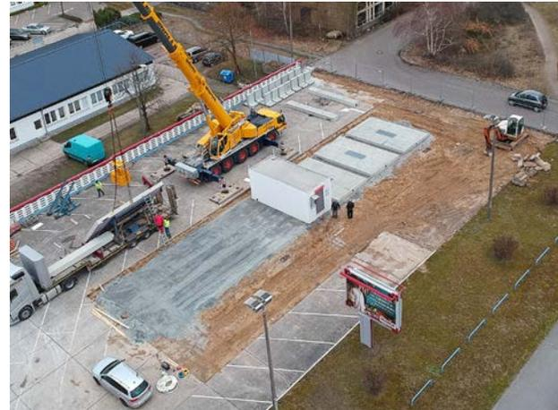
Mit Hilfe eines Mobilkrans werden der Beton-Fertigteil-Container, sowie die Waschplatten auf ein Splittbett gelgt
