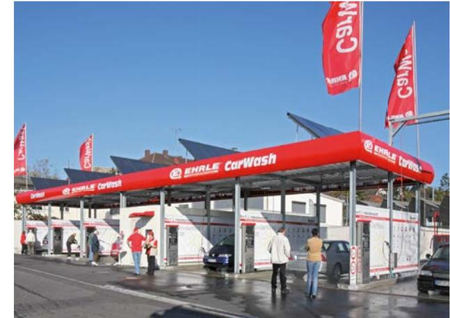
CarWash ModulLine 6 Waschplätze mit Beton-Technik Container und thermischer Solaranlage zur Wassererwärmung
