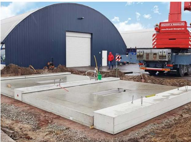
Innerhalb eines Arbeitstages sind die Beton-Fertigteil-Waschplatten fertig verlegt.
