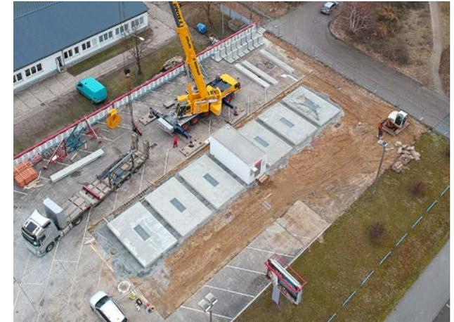
Nach Verlegung der Beton-Fertigteil-Waschplatten, werdem die Mittelriegel zwischen die Waschplatten gelegt
