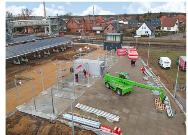
Der Stahlbau wird mit Klebeanker auf die vorhandenen Beton-Fertigteile fixiert.
