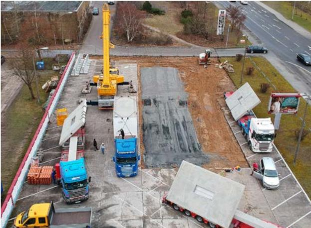
Transport mit Tieflader und Schrägbock direkt auf die Baustelle
